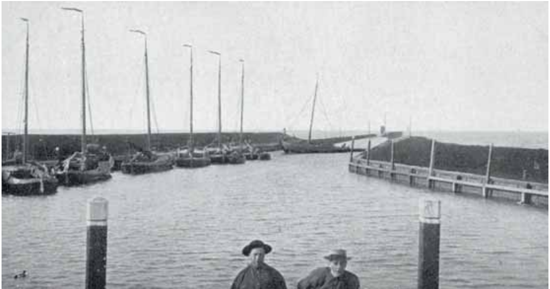
Overzicht van de pieren en de kade (rechts) met originele wrijfpalen, foto gemaakt tussen 1900 en 1905. collectie Utrechts archief
