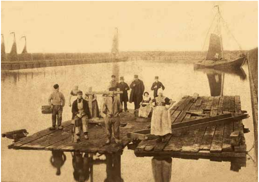
De Nieuwe Haven in gebruik, 8 oktober 1886 Op de foto naar aanname: De voorste twee personen zijn de aannemers de Ruiter en Schuyt. Op de achterste rij van links naar rechts, de heren Swets, Spruyt, Burgemeester Beukers en wethouder Rutger Beukers. Overige personen zijn niet bekend.
